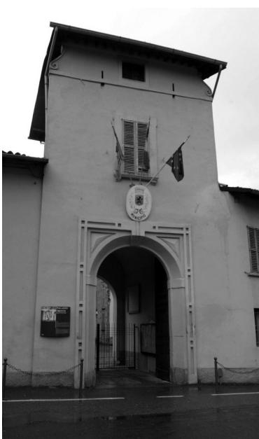
Palazzo Trotti, sede del Comune di Vimercate
